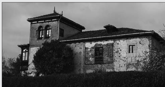
PALACETE EN LA CASA NUEVA CON LAS SEÑALES DE LOS COMBATES. FRENTE A ELLA SE REALIZÓ EL CRUCE DEL NALÓN POR LA BRIGADA VASCA. FOTO DEL AUTOR
