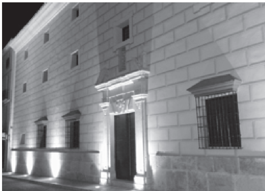
Fachada de la Casa de la Tercia
