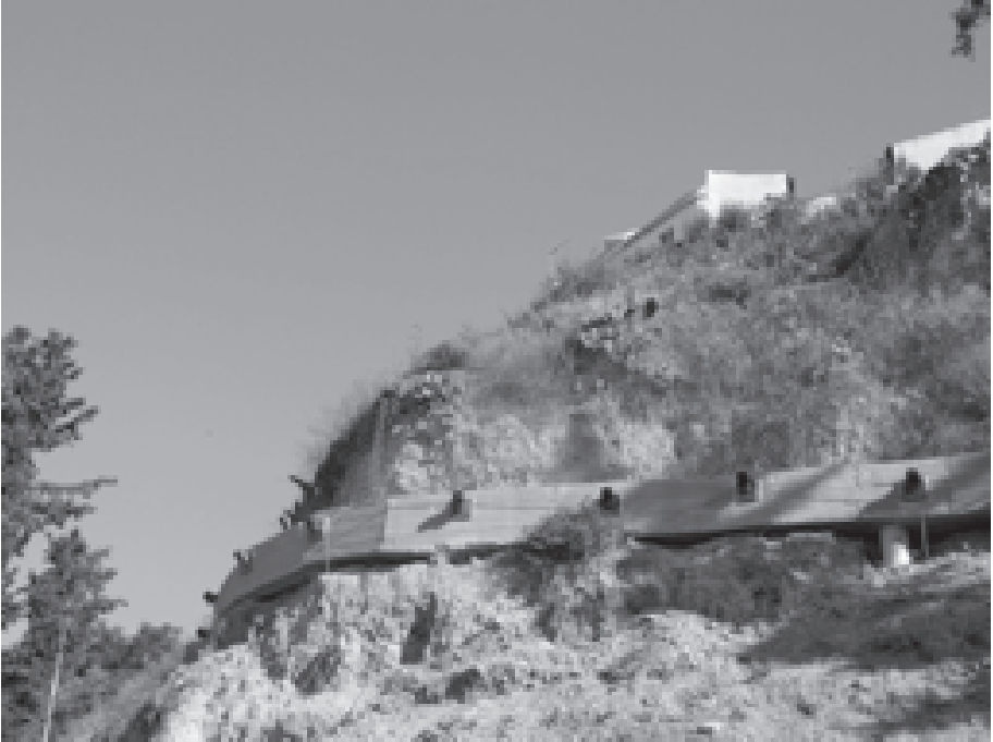
Afianzamiento de la muralla del barrio de la Villa
