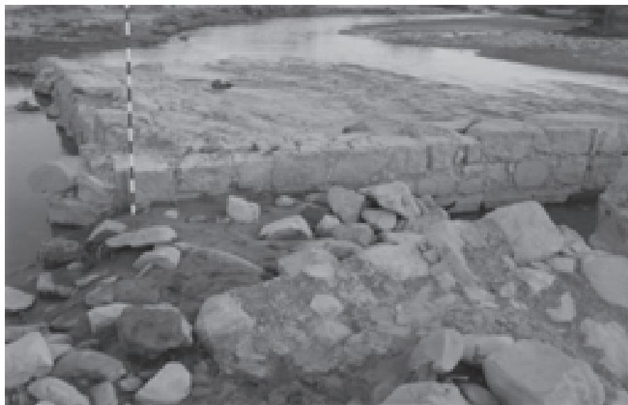
Lám. 3: Vestigios actuales del molino del Batán, ubicado igualmente en el río Monturque. En la fotografía se observa parte de sus canales y arquitectura. (Foto: J. López)
