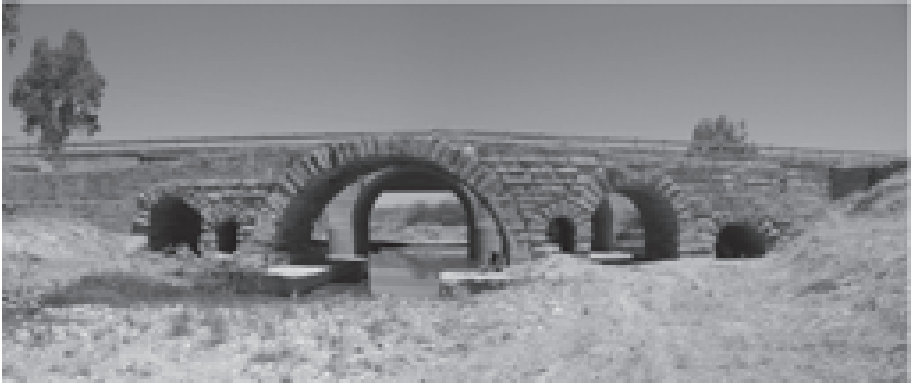
Ejemplo de construcción civil romana realizada en piedra molinaza. Puente sobre el arroyo Salado de Villa del Río
