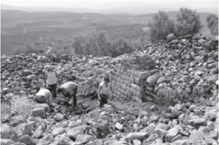
Trabajos de limpieza manual en la supuesta Ermita de la Vírgenes
