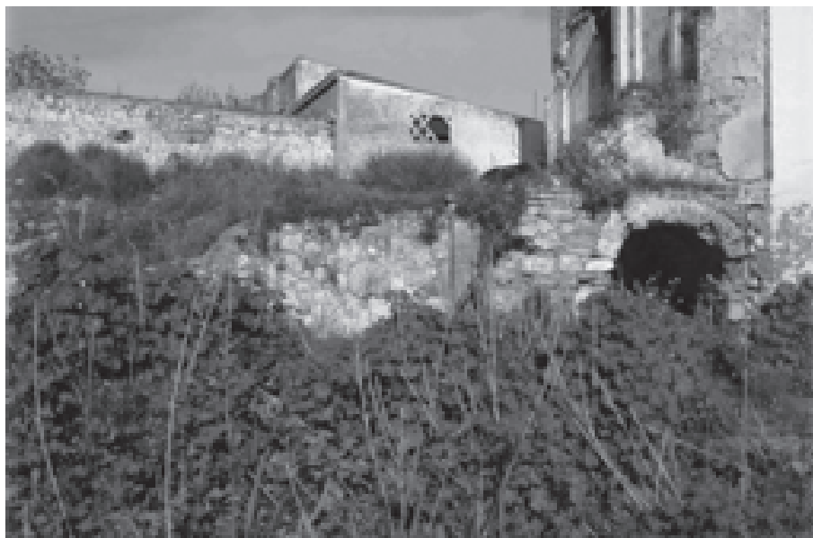
Lám. 1: Vano de entrada a la sala de molienda del molino de Don Martín, situado en el río Monturque. (Foto: J. López)
