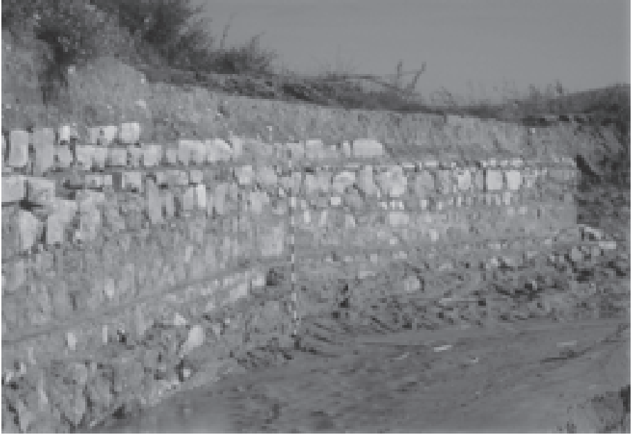
Lám. 2: Potente cao del molino del Hondón o de Fernando, localizado en el río Monturque. Está construido de mampostería con una altura de 2,50 m. (Foto: J. López)
