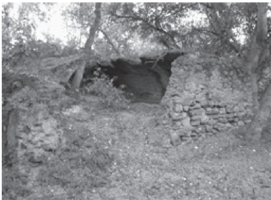
Lám. 5: Molina de la Cabeza del Obispo situada en el río Genil a su paso por Santaella. Consta de seis respiraderos, un ventanal frontal, un tejado a dos aguas y mismos materiales utilizados para toda su estructura. (Foto: J. López)
