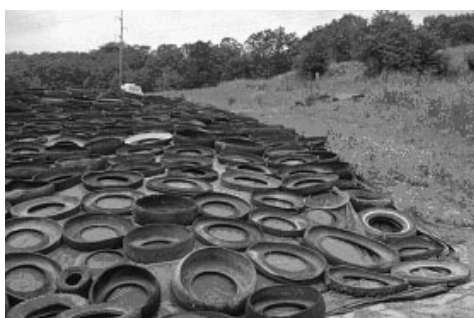
Figura 2. Imagen de silo tipo bunker, [1]
