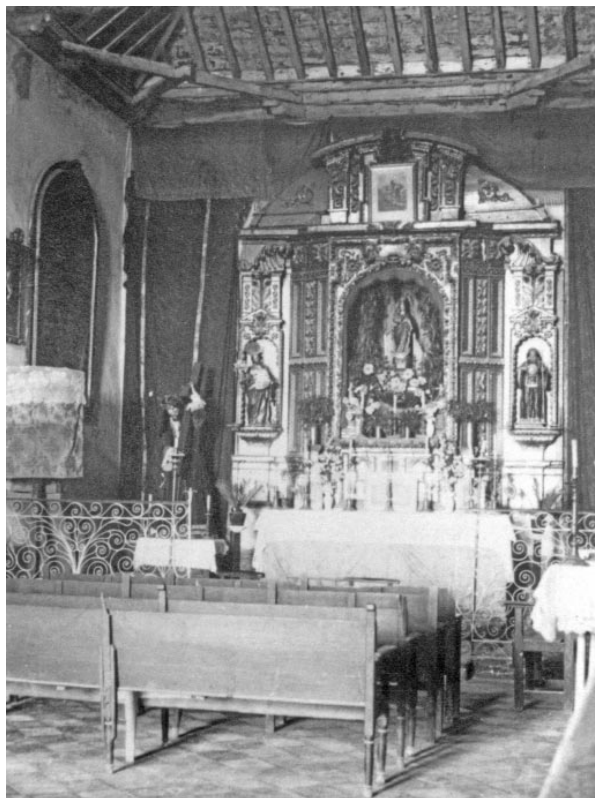
(figura 01). Iglesia del Peñón de Vélez de la Gomera antes de su demolición.
