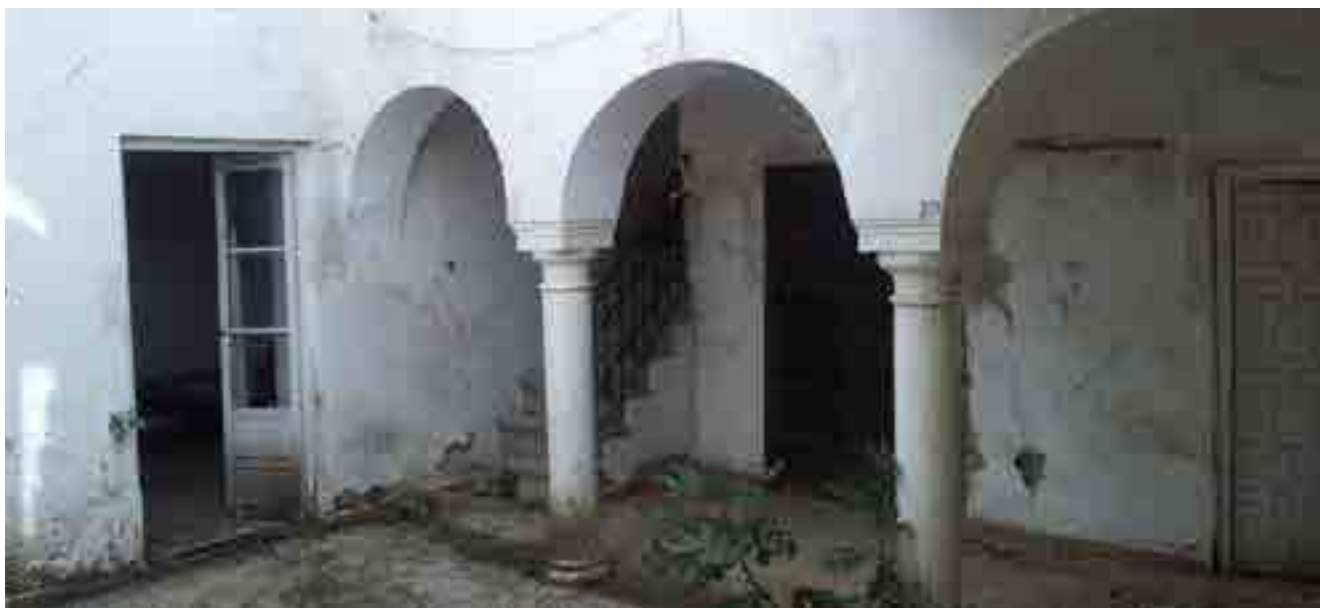
3. PATIO PRINCIPAL TRADICIONAL CON GALERÍA DE ARCOS DE MEDIO PUNTO. CASA SITUADA EN LA PLAZA RODRÍGUEZ MARÍN N.º 4
