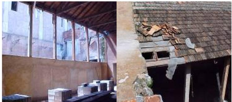
***Ilustraciones que muestran el deterioro de la cubierta y los soportes estructurales de madera que fueron necesario cambiar por una estructura duradera metálica.***
