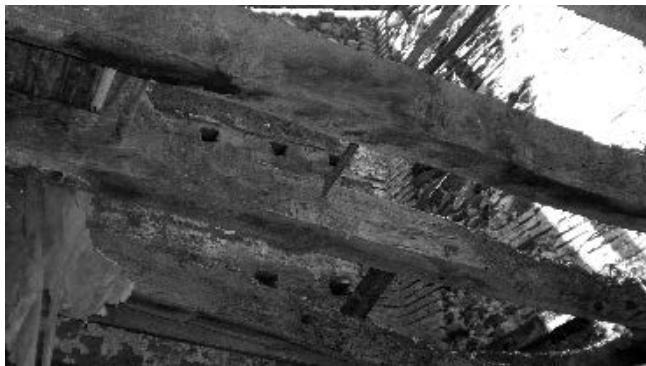
Vista de una de las cubiertas del Molino
