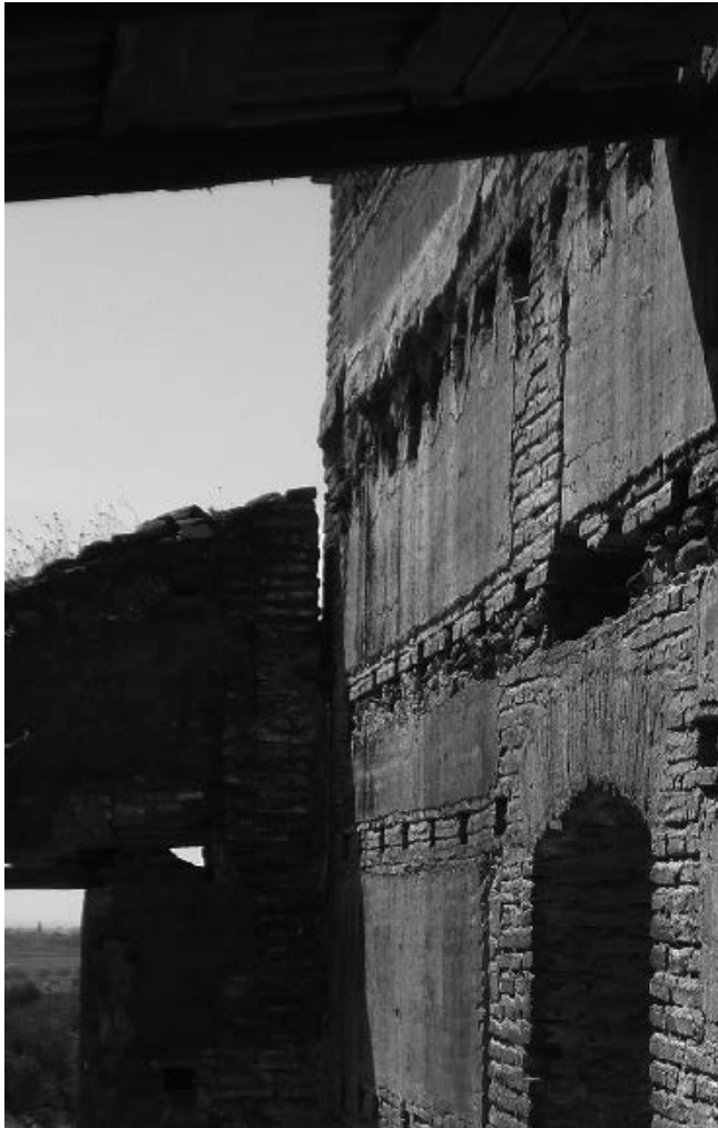
Vista de un muro del Molino
