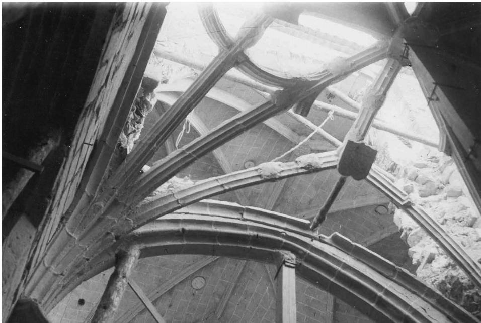
FIG. 6. Fotografía. Aquí podemos observar cómo quedó el esqueleto de la bóveda de crucería una vez desmontada (autor: Fernando Hurtado Collar).
