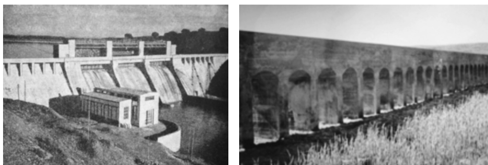
FIG. 2. Presa del pantano del Borbollón. Obras en la red de riego de la zona del Gabriel y Galán (fotografías: revista Vida Nueva y Archivo Central del Área de Medio Rural y Marino, Ministerio de Medio Ambiente y Medio Rural y Marino).
