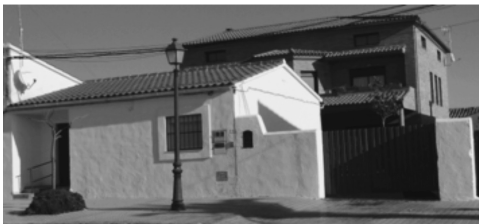
FIG. 11. (Sup.) Los amplios espacios alrededor de viviendas de obreros y colonos en Vegaviana están siendo pavimentados sin ningún tipo de criterio, alterando sustancialmente el concepto arquitectónico propuesto por Fernández del Amo. (Inf.) Tampoco la construcción de nuevas casas en los patios de las antiguas viviendas, cada vez más frecuente, constituyen el mejor ejemplo evolutivo de la vertiente arquitectónica de la colonización (Alagón del Río) (fotografías de los autores).
