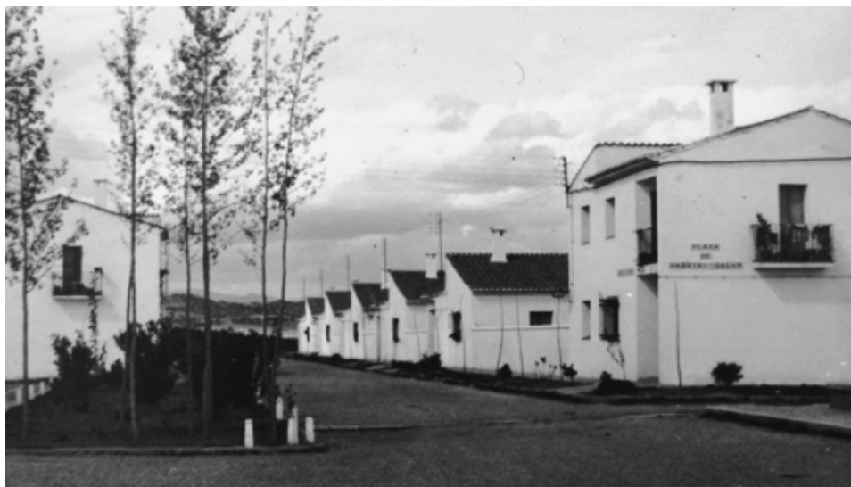
FIG. 5. Tipos de viviendas, Valderrosas (fotografía: Archivo Central del Área de Medio Rural y Marino, Ministerio de Medio Ambiente y Medio Rural y Marino).
