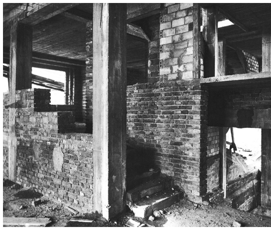
[20] Adolf Loos, villa Müller, Praga, 1930. Muro de articulación de niveles, en construcción. UPM Archive Prague. En The Müller Villa in Prague , City of Prague Museum, 2002.
