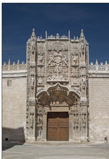
Figura 5 FACHADA DEL COLEGIO DE SAN GREGORIO
