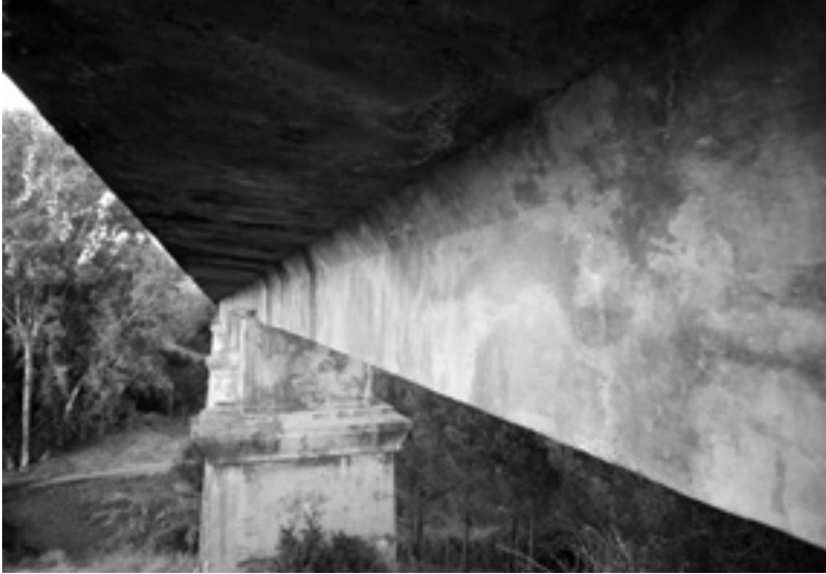
22. Viaducto sobre el río Fahala. Alero de viga de sección TT. Fotografía: Guillermo Ordóñez Ordóñez.
