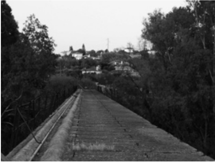
26. Viaducto sobre el rio Fahala. Plataforma. Fotografía: Guillermo Ordóñez Ordóñez.
