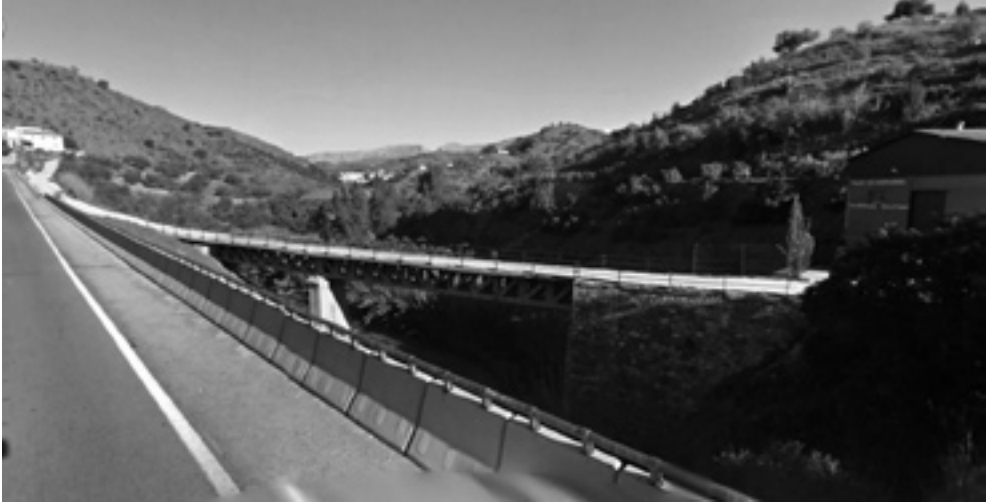
4. Puente sobre el río Bermuza. Fuente: Google Maps.
