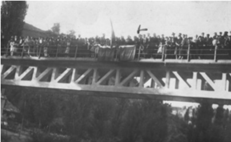
16. Viga en celosía del puente de carretera sobre el río Esla entre Santa Olaja de la Varga y Sabero (León) en el día de su inauguración en 1925. Autor desconocido. Fuente: Archivo Municipal de Sabero (León), cortesía de Manuel Castro Martínez.
