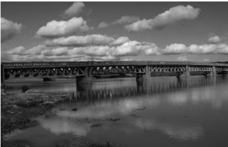
18. Vigas en celosía del puente de Alfonso XIII sobre el río Luccus, en la carretera de Tánger a Rabat, en las proximidades de Larache. Fuente: http://larache-historia.blogspot.com.es/2009_12_01_archive.html
