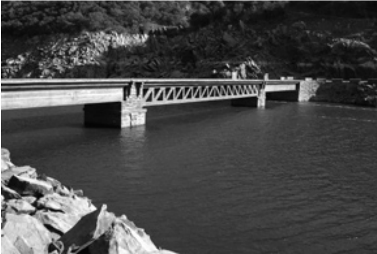
17. Viga en celosía del puente de carretera sobre el río Tajo en Serradilla. (Cáceres). Fuente: http://lascarreterasdeextremadura.blogspot.com.es/2013/12/el-puente-de-serradilla.html
