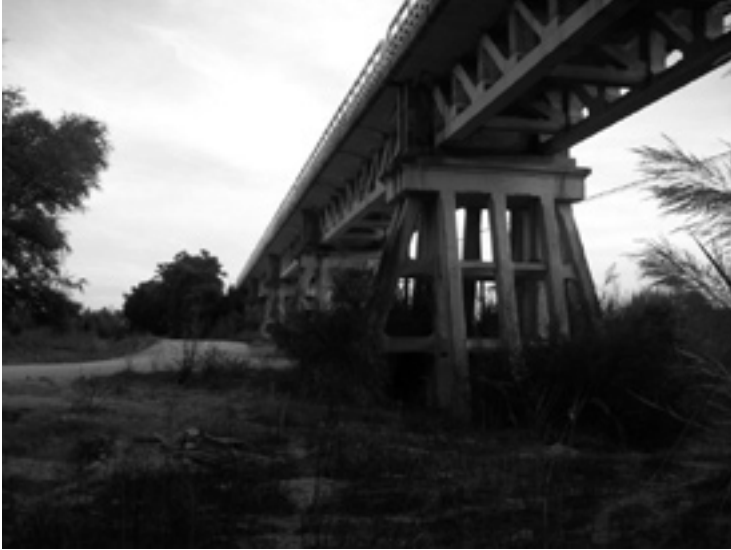
15. Viga en celosía del puente de carretera sobre el río Guadalquivir en Villanueva de la Reina (Jaén). Fuente: http://infoguadalquivir.blogspot.com.es/2010/10/puente-de-villanueva-de-la-reina-sobre.html
