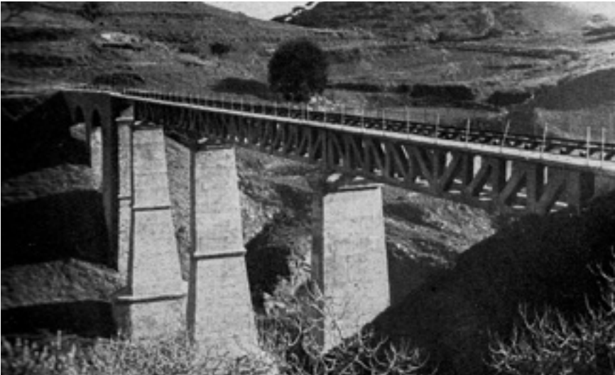
5. Viaducto sobre el Arroyo Hondo en 1942. Fuente: EXPLOTACION DE FERRO-CARRILES POR EL ESTADO, A., Memoria que presenta para el periodo 1 de julio 1941- 30 de diciembre 1942 el ingeniero director D. Alejandro Mendizábal Peña , Madrid, 1942.
