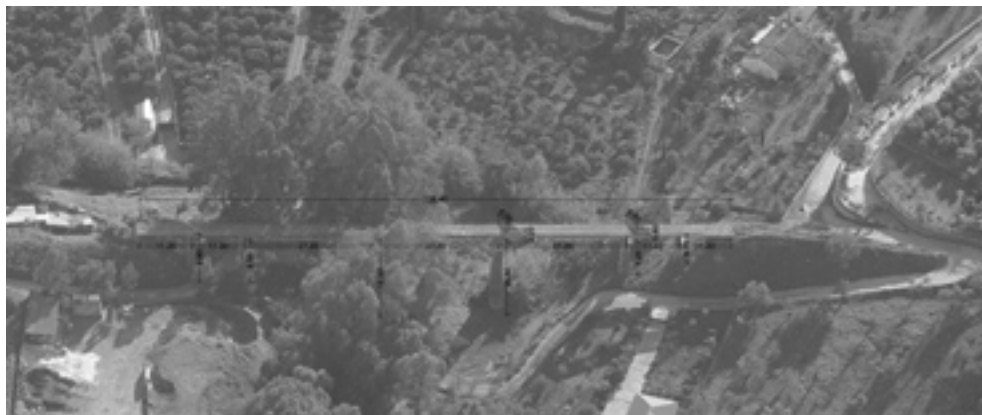
8. Viaducto sobre el río Fahala. Geometría. Autor: Guillermo Ordóñez Ordóñez, sobre fotografía de Google Maps.
