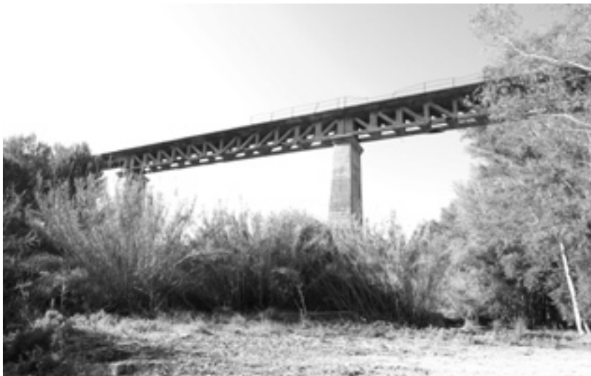
14. Viaducto sobre el río Fahala: tramos de viga en celosía. Fotografía: Guillermo Ordóñez.
