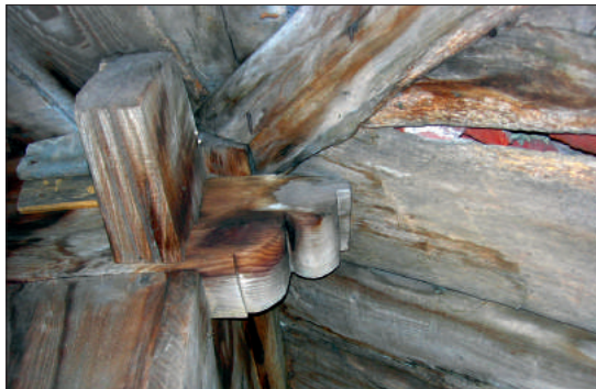
Figs. 14 y 15: Zapata del corredor construido en el claustro de San Pedro de Teverga hacia 1670 y cabeza de liño de la panera de Marcos Fernández, su propietario en el siglo XVIII (Banduxu, Proaza). En los siglos XVII y XVIII, los hórreos y paneras introducen repertorios estilísticos propios del arte barroco y neoclásico, como molduras a gola y bocel.
