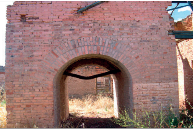
Fig. 14. Cuerpo inferior del horno de cemento principal.
