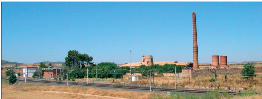
Fig. 27. Vista general del complejo fabril al inicio de su investigación, junto a la vía ferroviaria. 2004.
