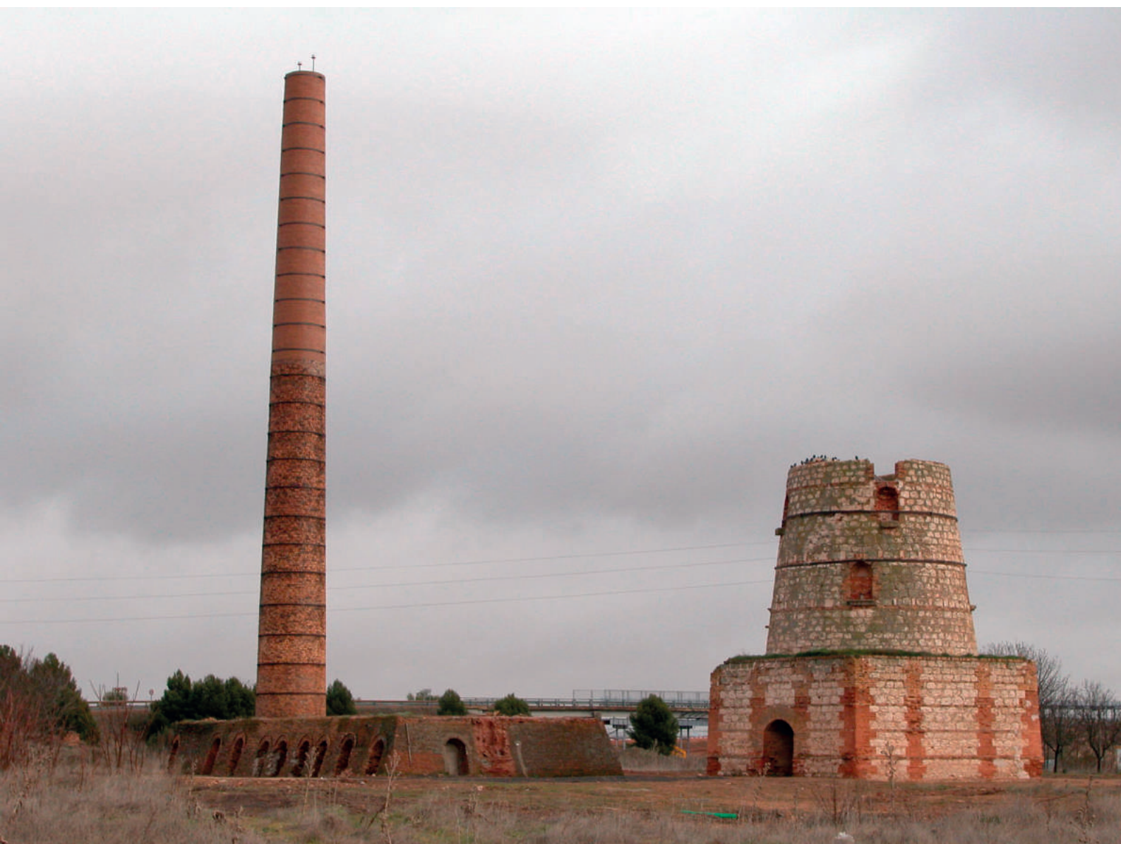
Fig. 31. Vista actual de los descontextualizados hornos principales de cemento y cerámica, con la chimenea reconstruida éste último. Los demás elementos del complejo fabril han desaparecido.
