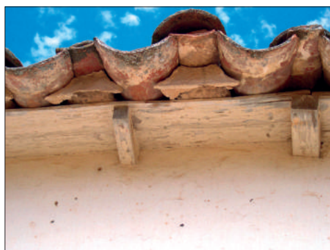
Fig. 21. Alero de las viviendas de los trabajadores, de teja volada a canal y cobertera sobre entablamento de madera.
