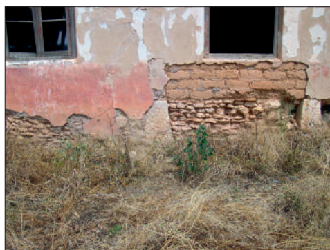
Fig. 20. Muros de adobe sobre zócalo de mampostería caliza de las viviendas de los trabajadores.
