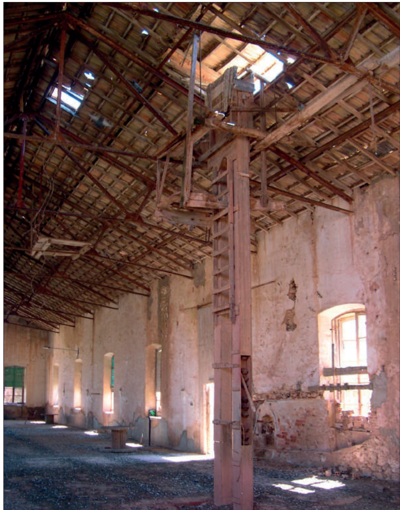
Fig. 4. Nave de amasado, cubierta mediante estructura de cerchas metálicas y teja plana, que no procede de esta fábrica. En primer plano se aprecia la cinta transportadora que, mediante canchales de madera, trasladaba los ladrillos frescos hacia el secadero anexo. Esta construcción fue demolida por completo, de forma innecesaria.
