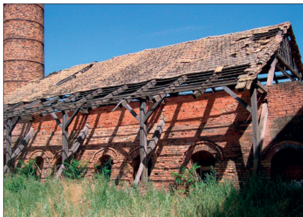
Fig.7. Cubierta del horno de cerámica principal. Fue innecesariamente desmontada.
