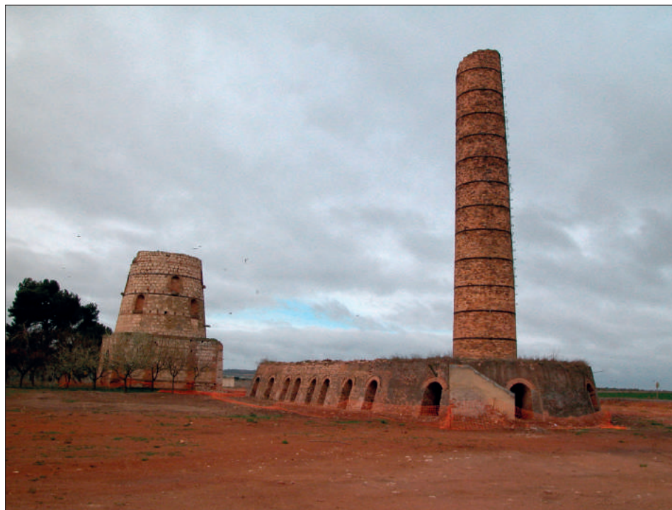
Fig. 30. Vista general del complejo industrial tras la demolición, a la cual sobrevivieron únicamente los hornos principales de cemento y cerámica (parcialmente). Imagen tomada en 2005.
