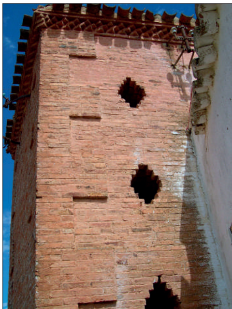
Fig. 22. Transformador de la Fábrica de Cerámica. Derribado.
