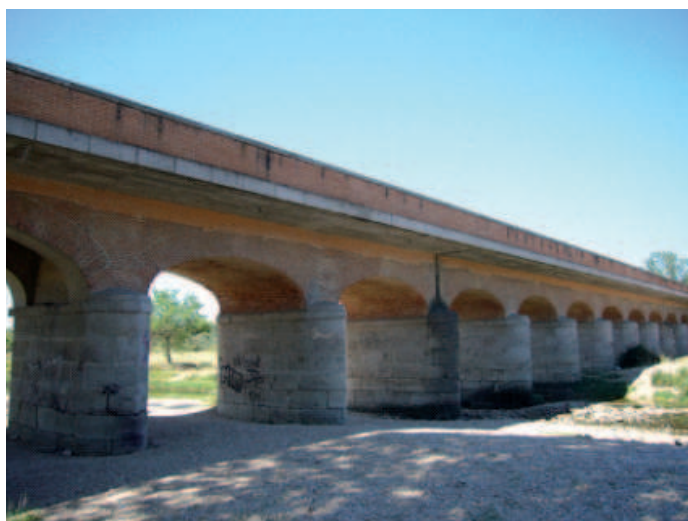
1 y 2. Villa del Prado. Puente de La Pedrera, estado actual. (Foto P. Corella, 2007).
