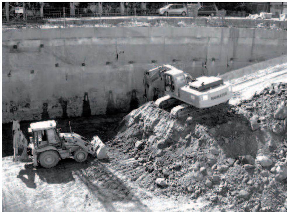
Fig. 4. Control arqueológico en movimiento de tierras en proyectos de edificación. Avda. de Córdoba.
