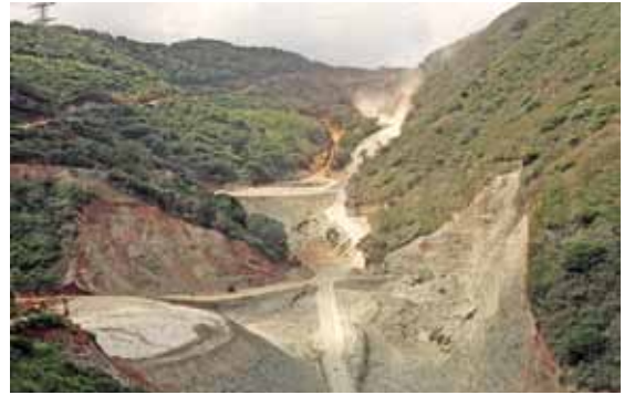
Figura 6. Proyecto en obras Ciudad Caribia. Fuente: Bocaranda Sardi 2011.
