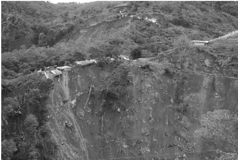
Fig. 1. Deslizamientos disparados por el Terremoto de Cinchona (2009) afectando obras de infraestructura habitacional y vial.
