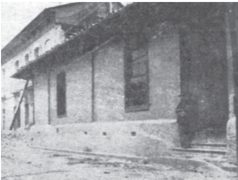
Figura 4. La casa donde vivió don Braulio Carrillo en San José (Fotografía modificada de Núñez 1945: 98). Nótese el techo de tejas, las dos gradas de acceso y una persona de pie, la ventana de guillotina y la sólida base del piso, con agujeros de ventilación. Columna derecha: Valor del terreno, de la mano de obra y de algunos materiales utilizados en la construcción de su casa en 1832. Costo total de la obra (pesos y reales) 2.667,3.
