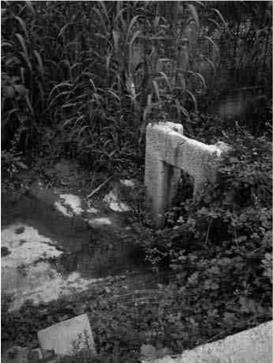
Detall d'un trestellador o comporta –una post de fusta encaixada dins les ranures de l'element de pedra permetia tancar i obrir el pas de l'aigua– de la Sèquia dels Molins, davant el Molí de Constantí, que exhibeix tres escuts de l'arquebisbe Ènnec de Vallterra (1380-1407).
