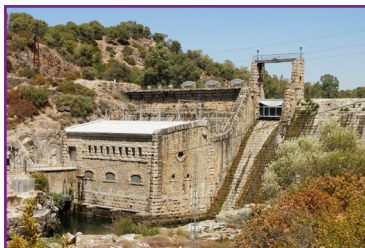
Imagen 4: Central hidroeléctrica y presa de Encinarejo (Jaén), vista aguas abajo. 23-08-2012.
