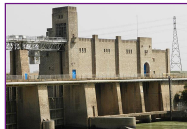
Imagen 5: Central de Alcalá del Río (Sevilla), fachada aguas abajo del Guadalquivir. 21-08-2012.
