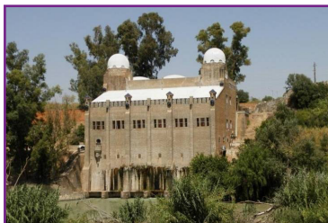
Imagen 2: Vista desde el río Guadalquivir de la Central hidroeléctrica de El Carpio (Córdoba) 22-08-2012.
