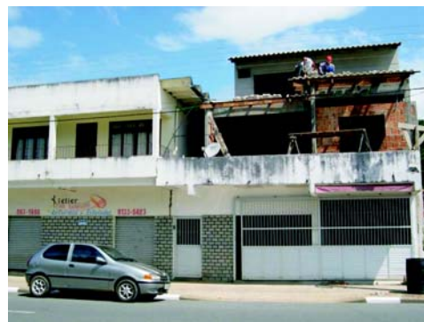
FIGURA 13 - CONSTRUÇÕES QUE MOSTRAM AS TRANSFORMAÇÕES ATUAIS NO BAIRRO DA BARRA
