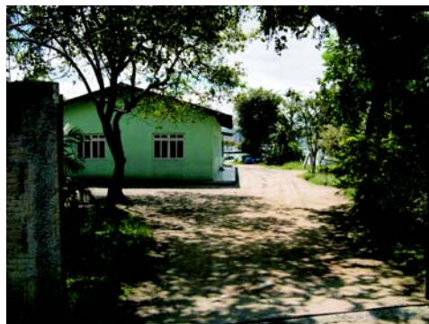
FIGURA 11 - EDIFICAÇÃO TRADICIONAL EM ALVENARIA
