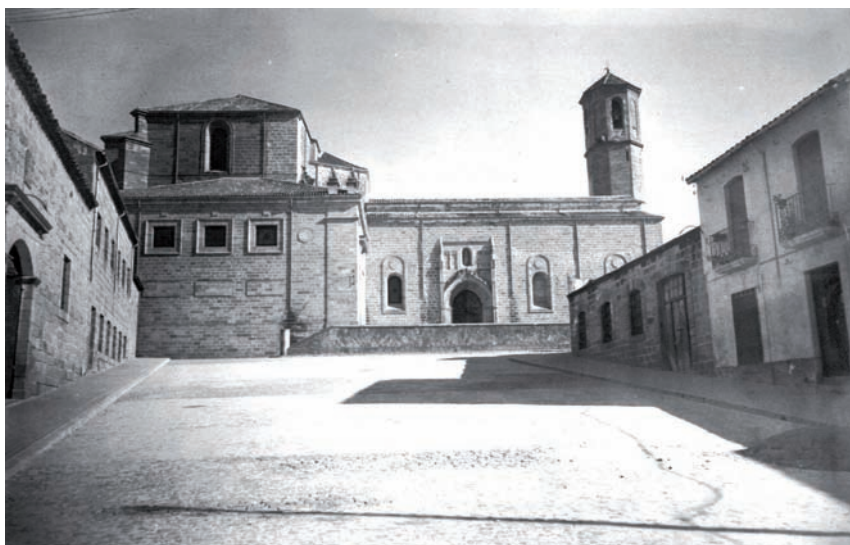
La foto de arriba nos muestra la iglesia en 1917 y la de abajo el resultado final de la reconstrucción. Archivo Municipal
