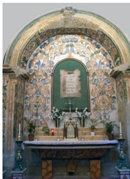
Actual estado de la capilla de acceso a la torre (Sagrario)
