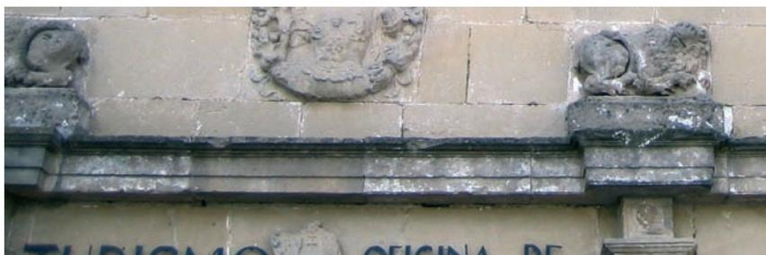
Fig. 9. Detalle de línea de imposta con pieza simplificada en la zona inferior
