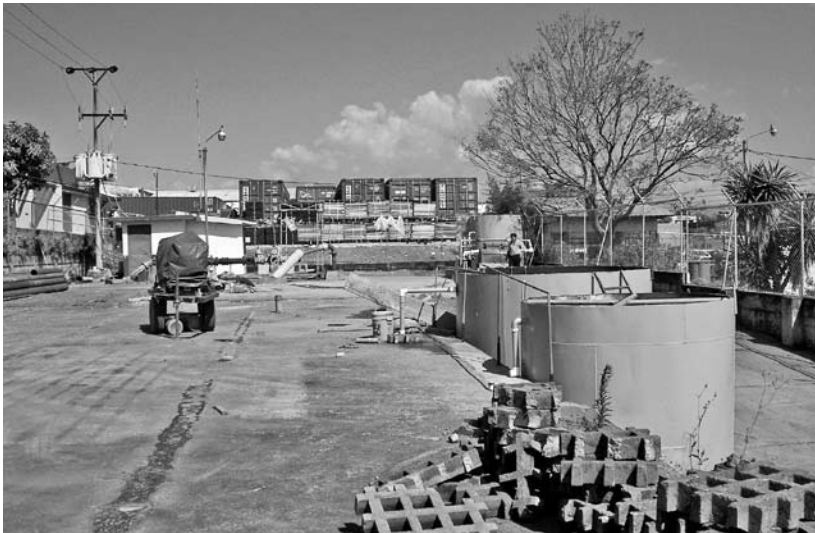
Figura 2. Vista del plantel de separación de hidrocarburos.
