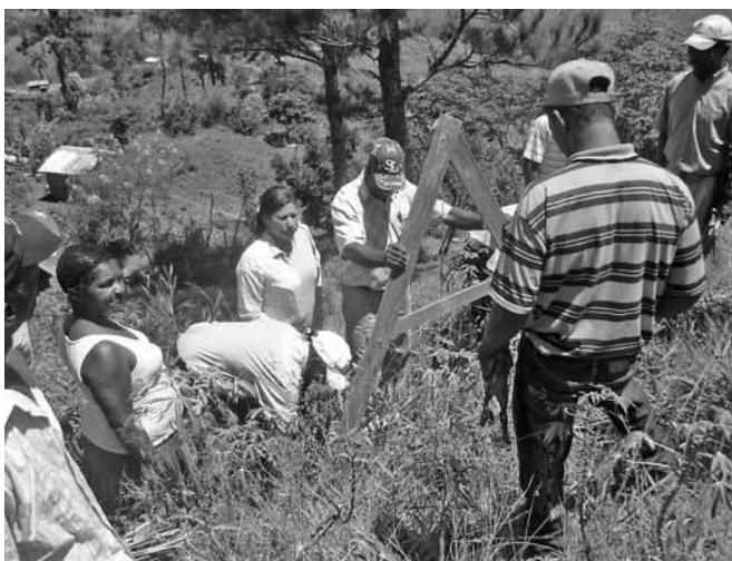
Figura 6. Instalación de barreras en la comunidad Las Cañitas.
