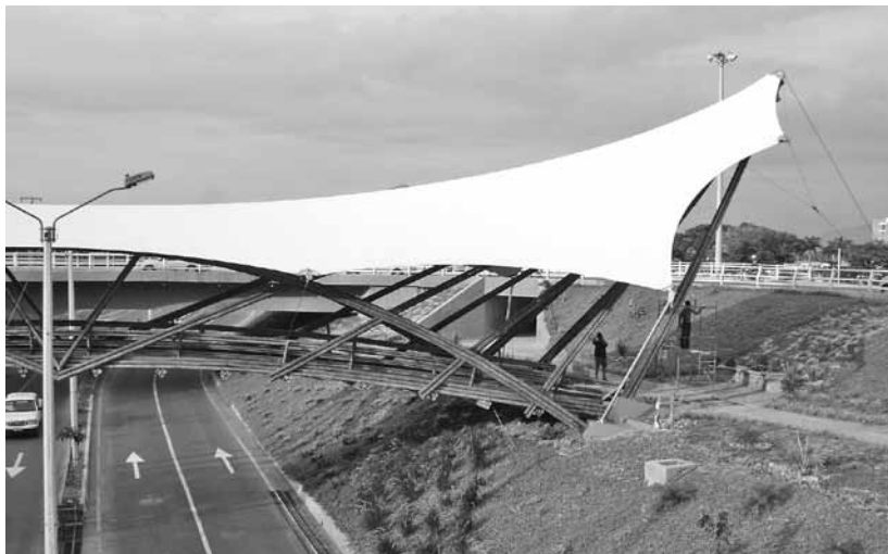
Figura N.º 1. Puente sobre la Avenida Libertadores y Rotonda Arnulfo Briceño, Jörg Stamm.
