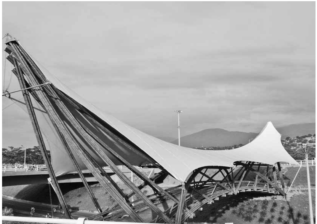
Figura N.º 11. Puente en Cúcuta, Colombia. Detalle de las tirantas, Jörg Stamm.
