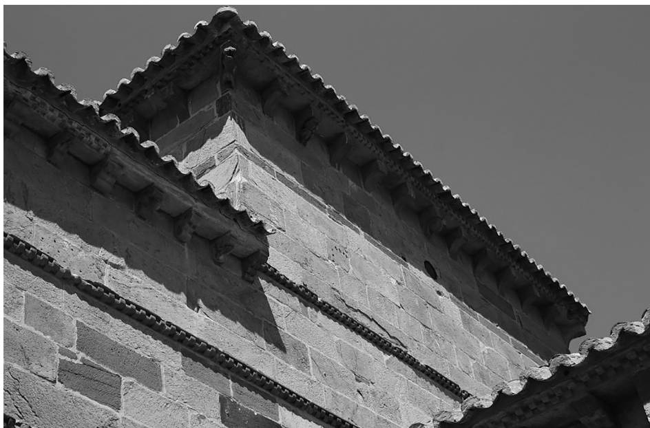
Figura 1. Cimborrio con el óculo este.
