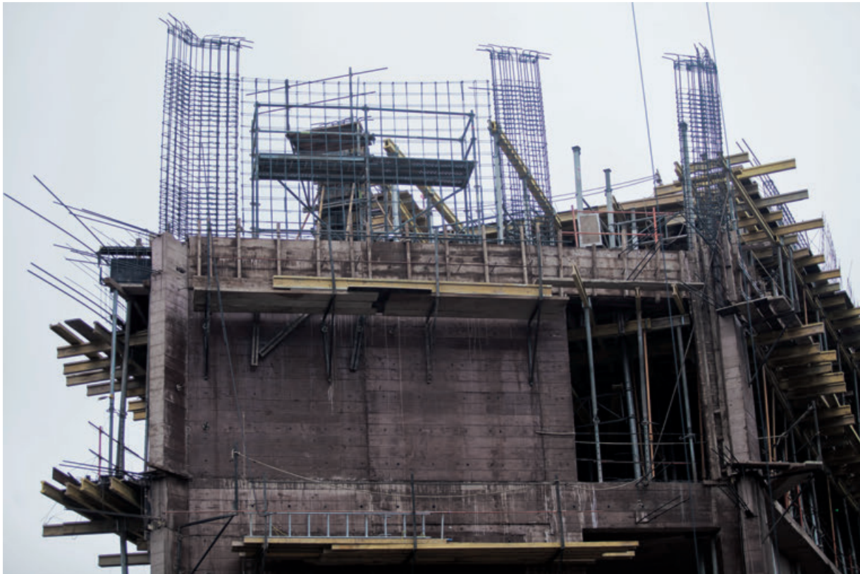
Fotografías tomadas durante la fase de construcción, la primera semana de julio de 2014.
