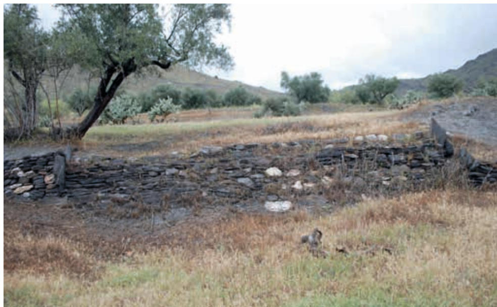
Fig. 3. Los sangradores son vertederos que comunican un bancale con el siguiente situado a cota inferior. Rambla Honda (Almería).
