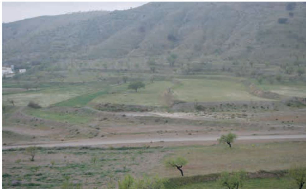
Fig. 1. El riego por boquera y aprovechamiento de turbias, es una técnica tradicional usada para regar cultivos de secano en el Sureste español. Los diques de tierra desvían el agua de la rambla a los bancales escalonados de las márgenes. Rambla de Santa María de Nieva (Almería).
