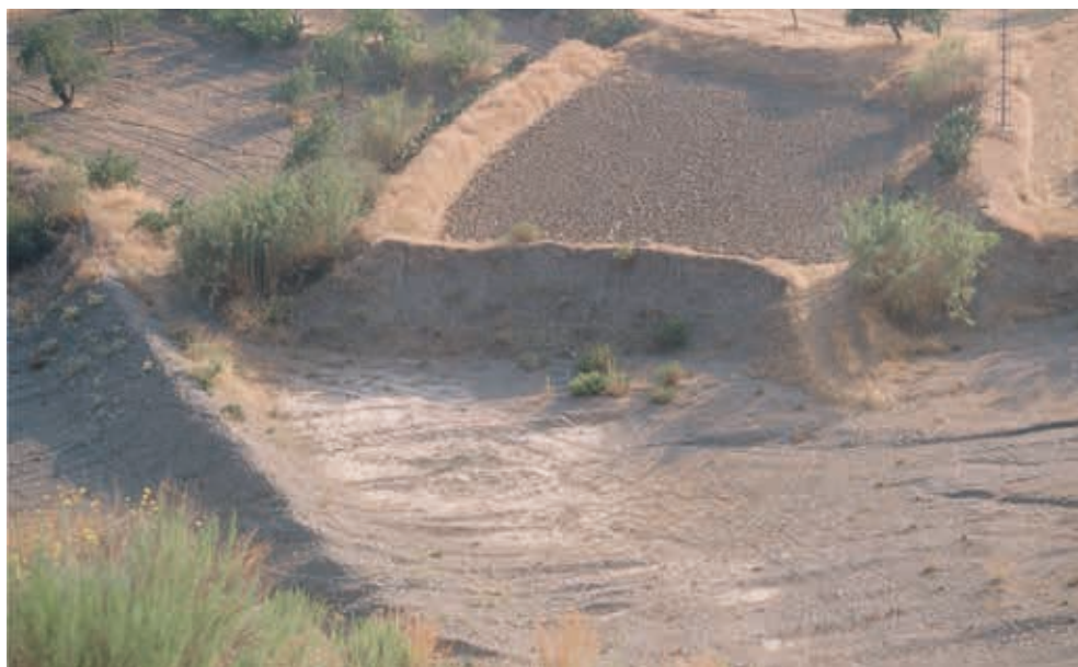
Fig. 2. Boquera y presa de desviación que intercepta y conduce parte de las aguas de la rambla hacia los bancales.
