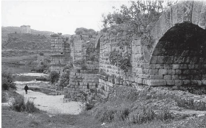
**Figura 33.** Vista del puente romano de Alconétar desde su cara norte. Se puede apreciar el detalle de los pilares, que tenían tajamar (rompeaguas) en ángulo en toda su altura para recibir la corriente del río. Al fondo la torre del castillo de Floripes, que controlaba el paso del puente al otro extremo. Fotografía de Wifredo López.
