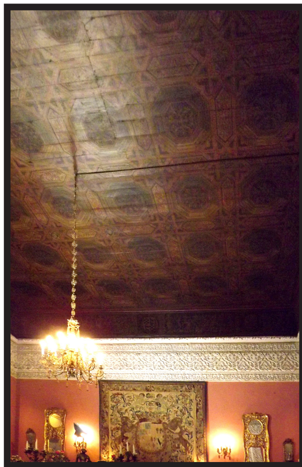
Fig. 1. Vista de la techumbre. (Foto: Esther Albendea).
