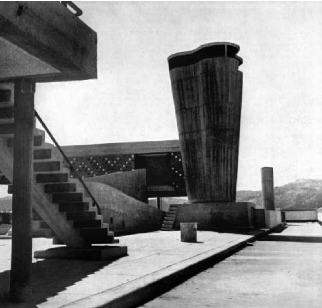
Chimenea de ventilación de la cubierta de la Unidad de Habitación de Marsella, 1946-1952
