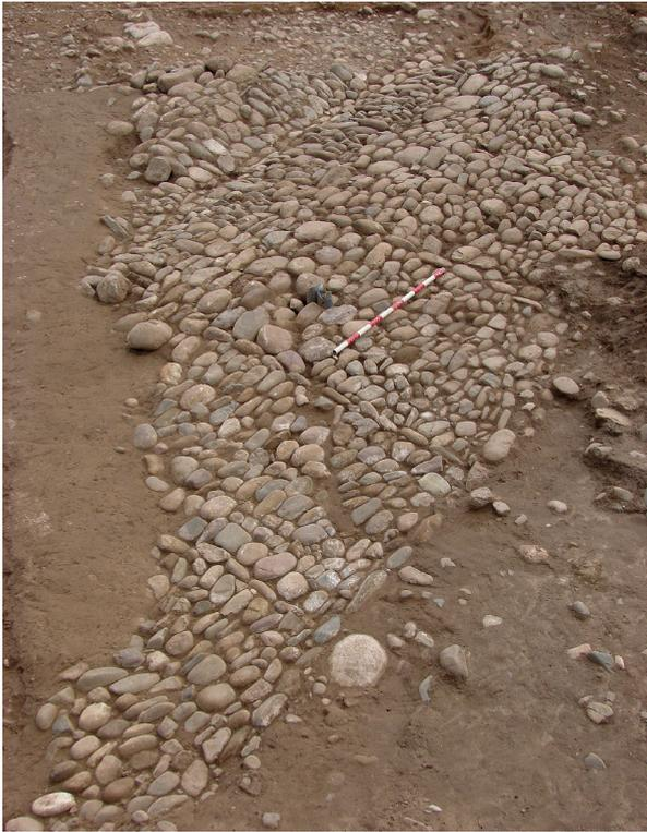
*Figura 8. Reposición realizada en momentos finales de la Edad Moderna mediante un empedrado de canto rodado organizado en cuarteles regulares, con limaboyas.*
