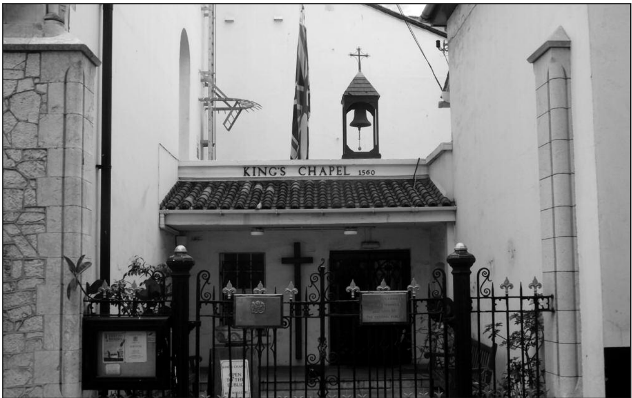
Figura 1. Fachada principal de la capilla del Rey en Gibraltar. Foto autor.
