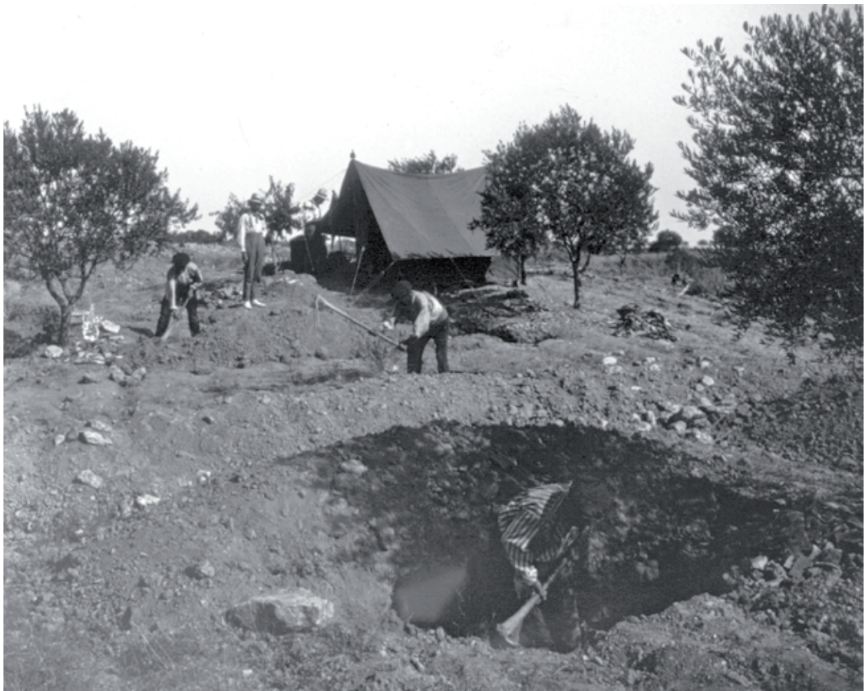
Vista de les excavacions en curs de la campanya de 1915. (Fotografia de Manuel Herrera i Ges. Fons documental del Museu Diocesà i Comarcal de Lleida). Fig. 1.
