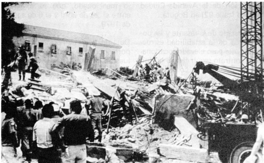
El Prado. Vista general del efecto del colapso.
