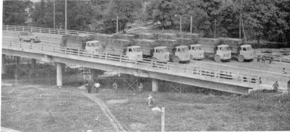
Puente de la calle 92. Ensayo de carga.
