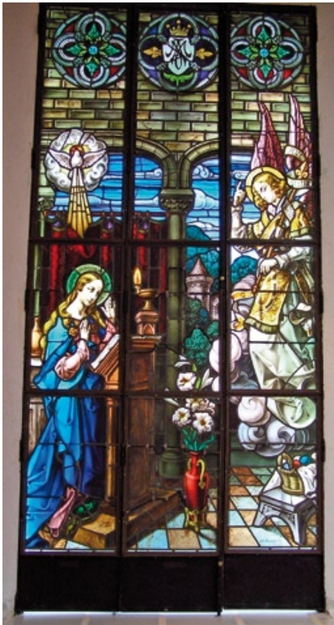
Fot. 1. Vista general de la vidriera de la Anunciación, en la que puede observarse su instalación en forma de puerta abatible de tres marcos, cada uno de ellos compuesto por tres paneles
