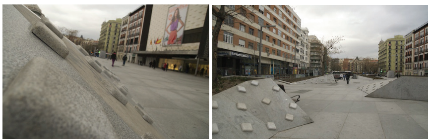
Skatestoppers en forma de pequeños bloques de cemento en la plaza de la Avenida Felipe II de Madrid Fuente: Diario Local Zona Retiro (08/03/2011) 7
