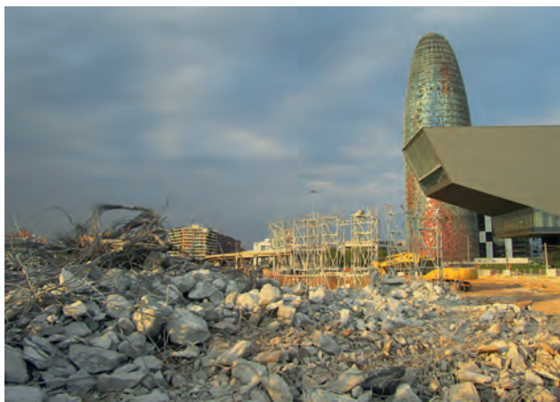
(Figura 12) Tras las obras de «deconstrucción» de la plaza de las Glorias, se perfilan el Museo del Diseño (conocido como «la grapadora») y la Torre Agbar, Barcelona, 2014. Foto del autor.
