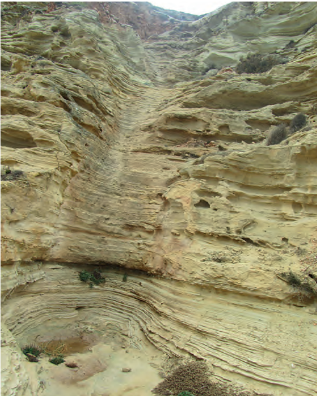
(Figura 8) Terrazas de arenisca en la carretera a Aguadú, diseñada por el ingeniero Job Placencia Valero, Melilla, 2014. Foto del autor.
