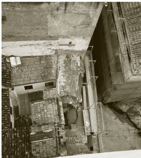
Foto 11. Vista cenital del tramo del número 32-34 que aparecía en las fotos 4 y 5, tras la excavación. El hueco central corresponde al tejadillo de Uralita
