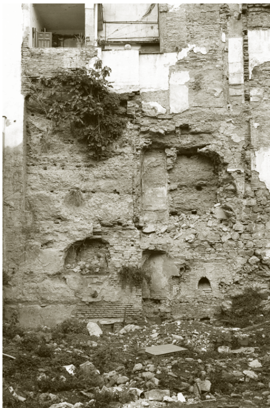
Foto 2. Vista del tramo izquierdo del fragmento correspondiente al número 28 de calle Carretería. Los materiales de la muralla han sido excavados para el aprovechamiento del espacio, instalándose una serie de estructuras que corresponden a hornos, hornacinas y canalizaciones de agua
