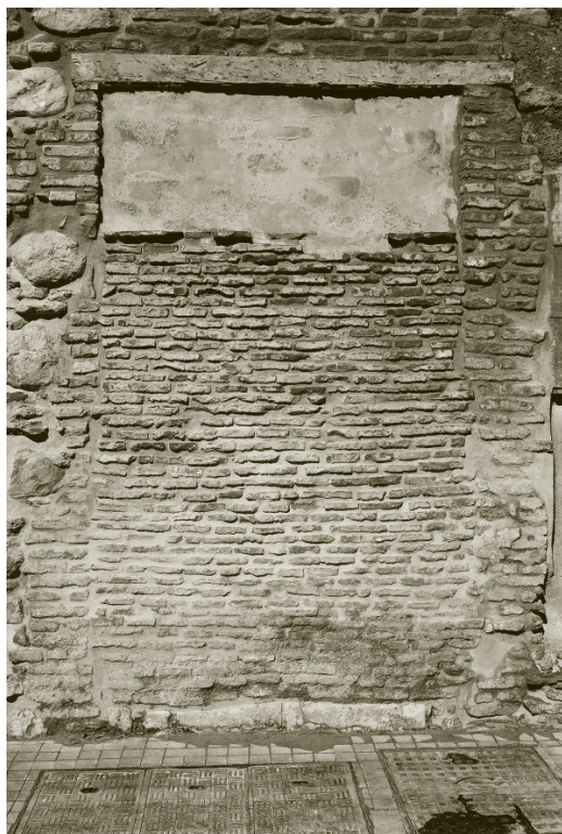
Foto 10. Detalle del vano tapiado que aparece en el número 32 y que se corresponde con un vano marcado en la estructura de tapial sobre el cual se montó una estructura circular con sillares de toba excavada durante la intervención
