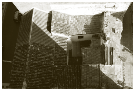
Foto 4. Vista cenital del fragmento correspondiente al número 32-34. A la derecha de los tejados aparece la terraza del edificio, construida sobre la muralla
