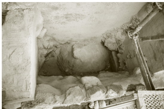
Foto 6. Detalle del trasdós de la bóveda del horno tras la excavación de los rellenos, en el tramo del número 28. En el momento de la fotografía, se han cerrado los muros perimetrales para evitar derrumbes. Y consolidar las estructuras originales circundantes
