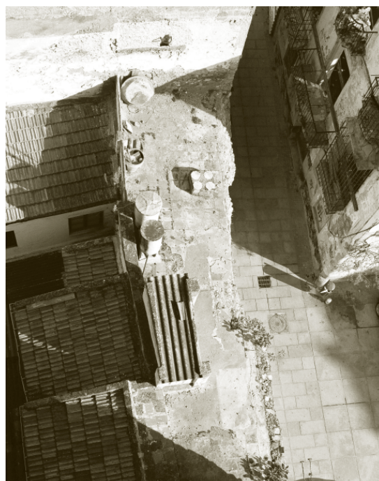
Foto 5. Detalle de la fotografía anterior. El tejadillo de Uralita, sobre la caja de escaleras, coincide con el vano que aparecerá en la cara intramuros y con la estructura circular que aparecerá tras la excavación del suelo de la terraza
