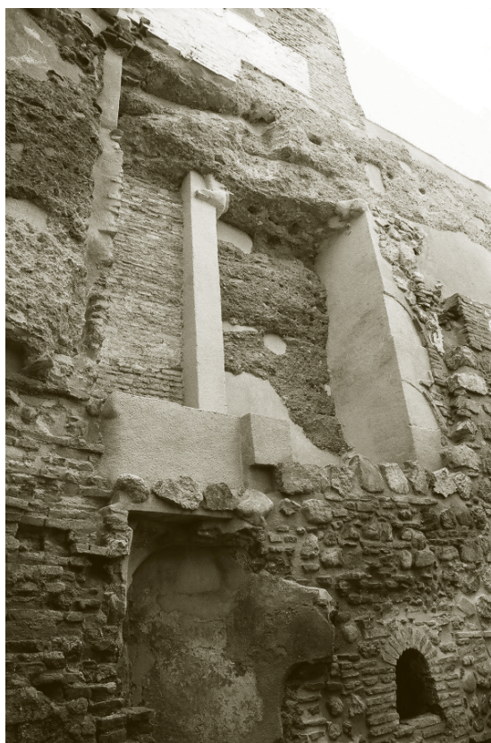
Foto 7. Vista de la zona que aparece en la foto 2. Se han levantado muros sobre las superficies circundantes y se han consolidado las estructuras originales. Se ha reconstruido el pilar central para indicar la existencia de dos espacios diferenciados. Es de la izquierda era un baño de una de las casas demolidas y el de la derecha era un relleno sobre el horno cuya función no se ha podido documentar
