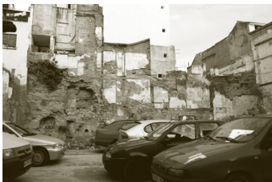
Foto 1. Vista general del fragmento de muralla medieval de Málaga en calle Arco de la Cabeza, correspondiente a los números 28, 30, 32 y 34 de calle Carretería. Los edificios adosados a la muralla se han demolido pero se conservan restos de sus materiales aún adheridos a la superficie de la misma
