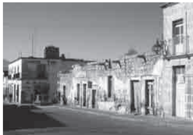
FIGURA 5. Patrimonio edificado en mal estado de conservación. Calle Vicente Santa María. (Fotografía Eugenio Mercado López, 2011).
