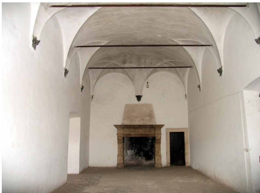
Lámina 15. Salón de Occidente con bóveda de medio cañón y lunetos, sostenidos con ménsulas de piedra talladas en Italia (J. M. Gómez-Moreno Calera)
