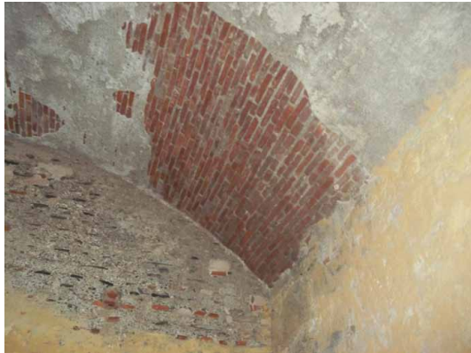
Láminas 13 y 14. Patio conocido como de las Damas o de la Servidumbre y detalle de la bóveda de ladrillos sobre la que se monta
