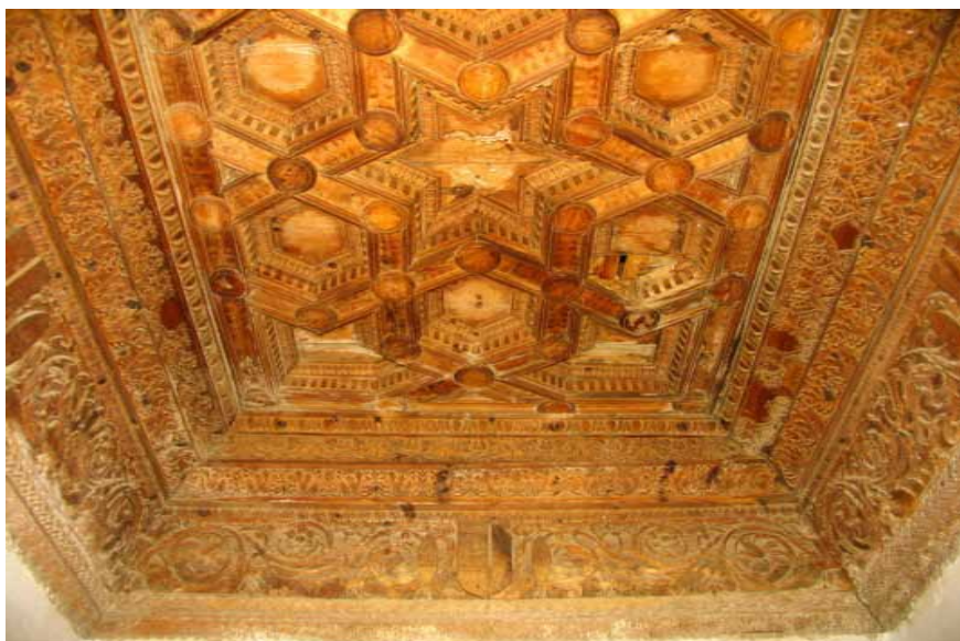
Lámina 5. Vista parcial del techo de la Capilla del palacio de la Calahorra (J. M. Gómez-Moreno Calera)
