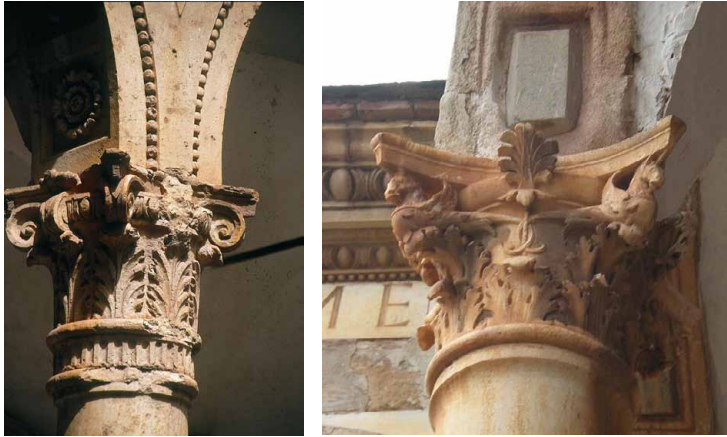
Láminas 7 y 8. Capiteles de la planta baja y primer piso atribuidos a L. Vázquez y M. Carlone respectivamente
