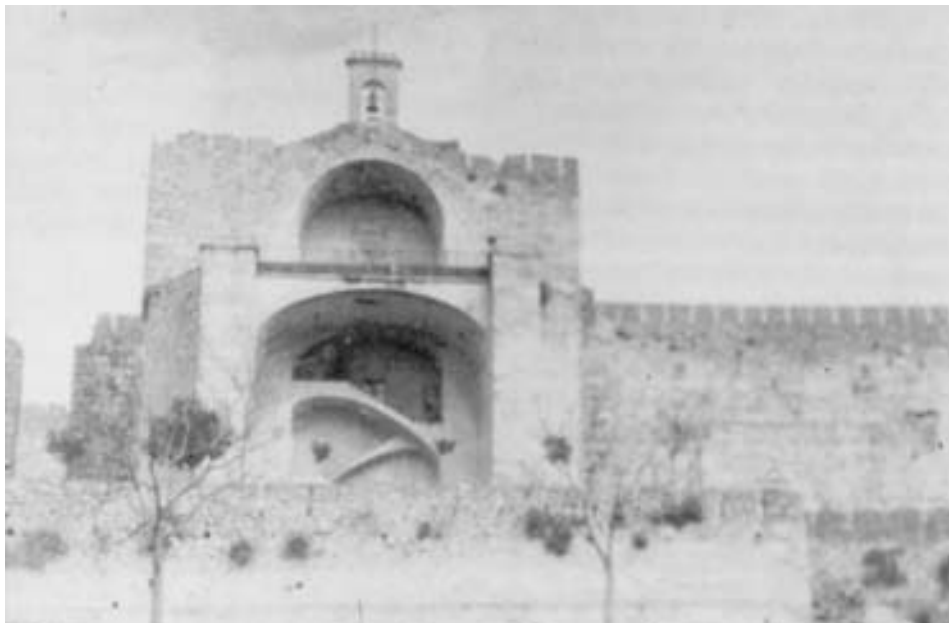
FIG. 2. Imagen del estado del Castillo tras la restauración de 1929.
