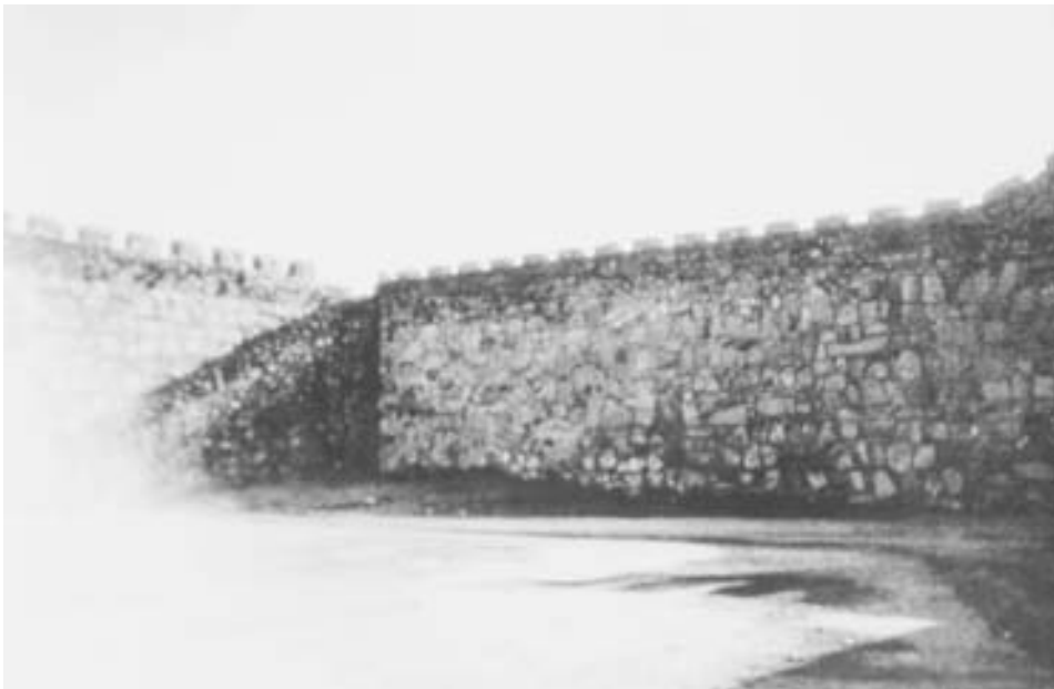
FIG. 4. Imagen de la casa del santero y la muralla, y el estado actual en el mismo lugar, donde se observan las escaleras que se hacen en el muro y la desaparición la casa del santero.
