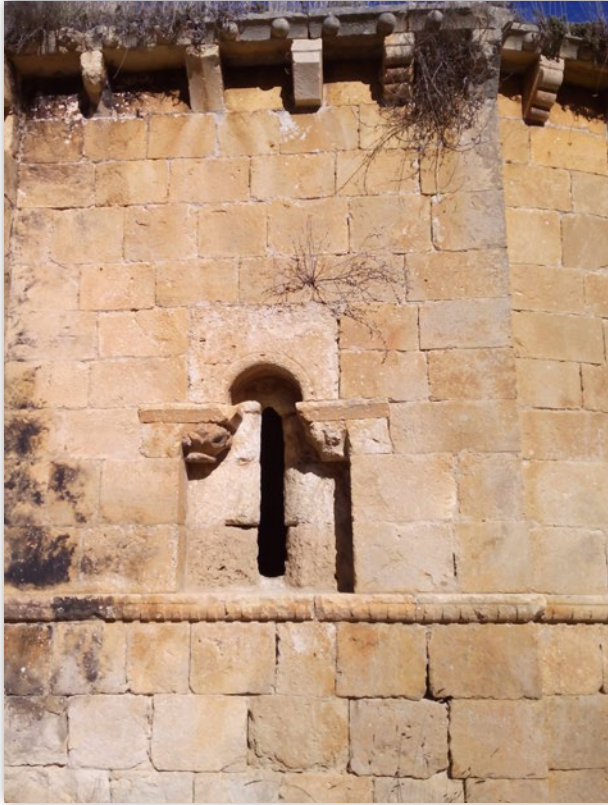
Exterior de la cabecera de Casuar: en primer plano, ventana y encintado. En la parte superior, una línea de cornisa con canchillos e imposta decorada con bolas.
