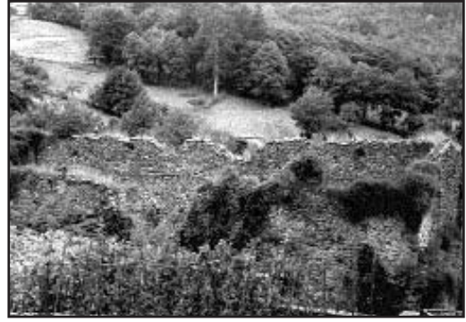
Fig. 21: Restos de la ferrería del Salto del Oso, Ramales (fotografía de la autora)
