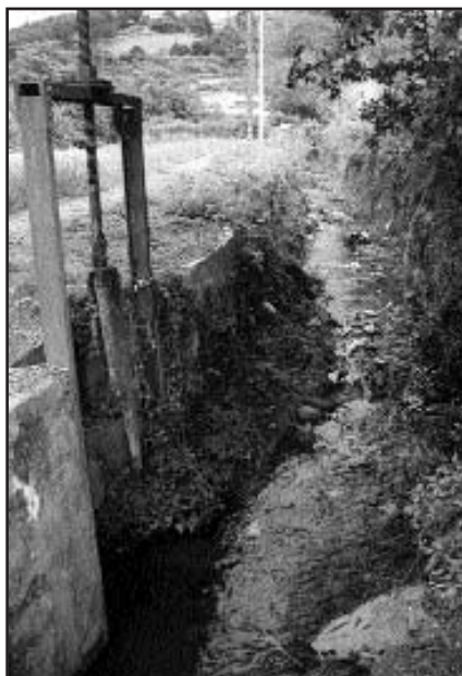
Fig. 8: Cauce y aliviadero de la ferrería de La Riera (fotografía de la autora)
