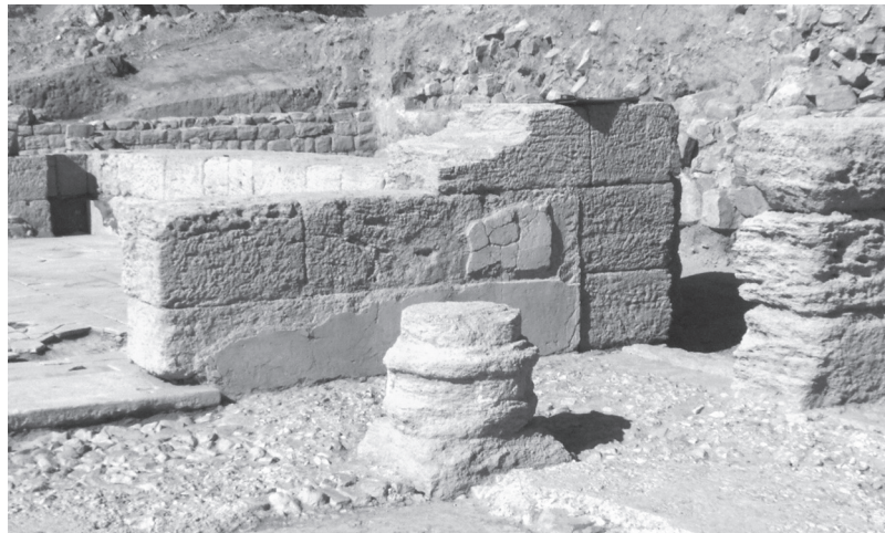
Fig. 9: Detalle patrón opus quadratum isódomo marmóreo.
