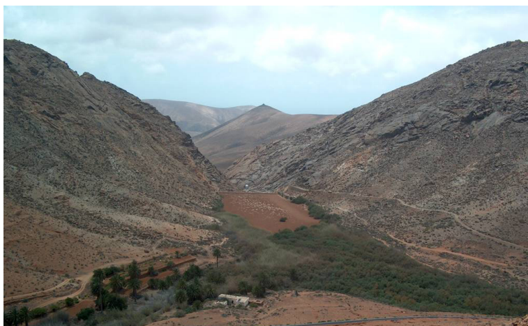
Imagen 2. Presa Las Peñitas colmatada de suelo (Fuerteventura).
