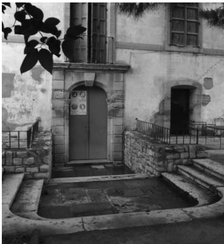
Portada Oeste, correspondiente a la escalera principal.
