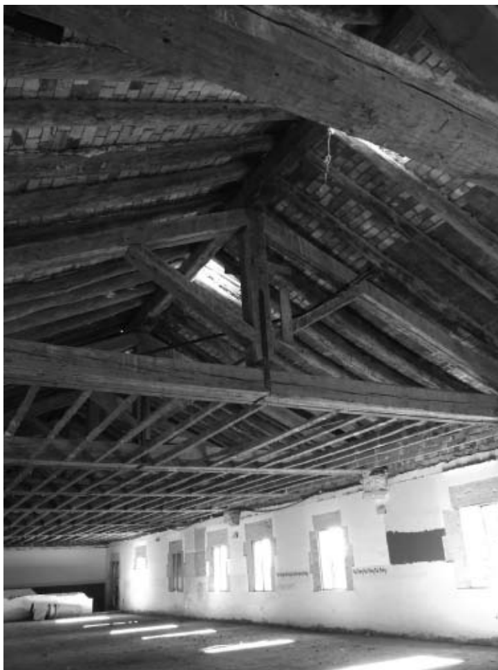
Vista de la techumbre.
