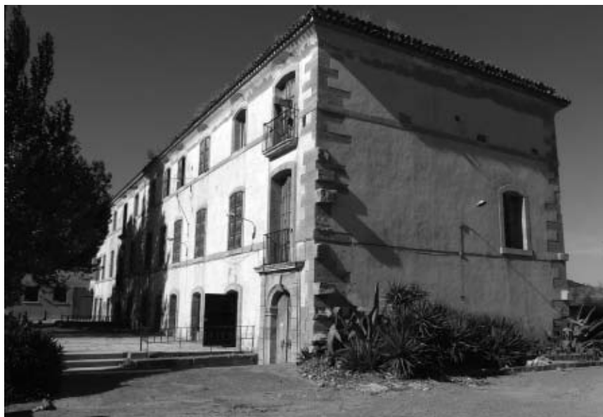
Vista general desde el Suroeste.
